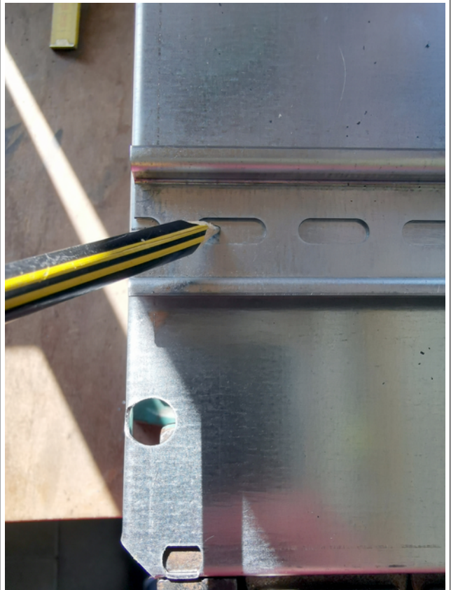
Figure 6 : Rails du chapeau supérieur complètement installés
